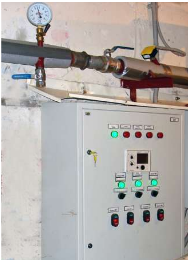
ИТП. Система автоматизированного управления теплоснабжением
