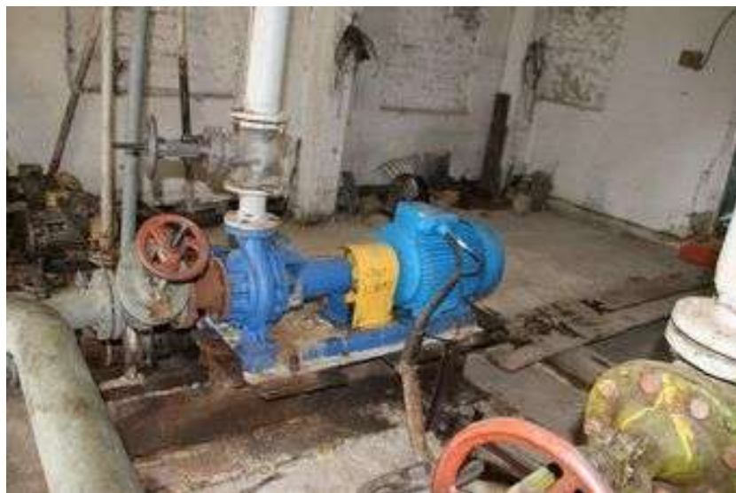
Рис.4. Состояние теплоисточника с.Рыбниковское
